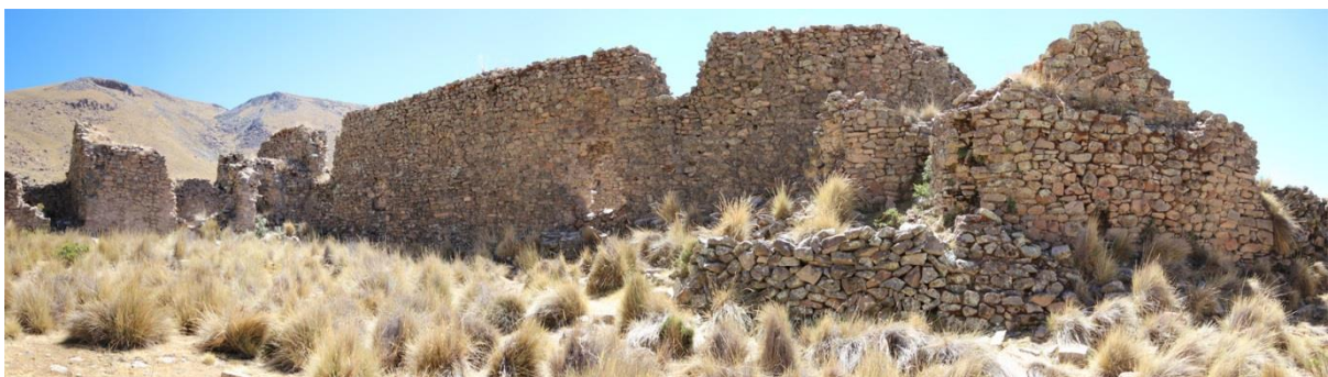
Figura 31. Vista externa del muro sur de la iglesia, desde la entrada al convento (desde el sureste)
