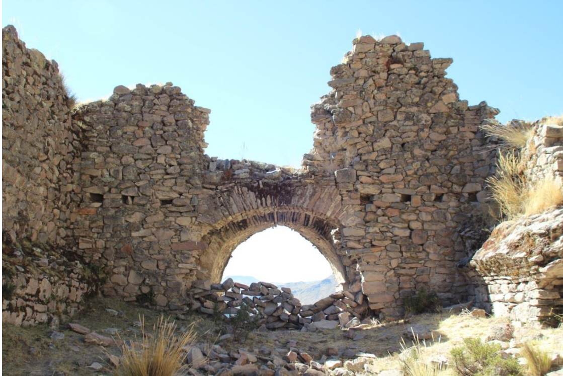
Figura 18. Vista interior del portal y las bases de la posible bóveda de entrada. Nótese las hornacinas o receptáculos para maderas de apoyo, posiblemente para sostener un balcón de madera.
