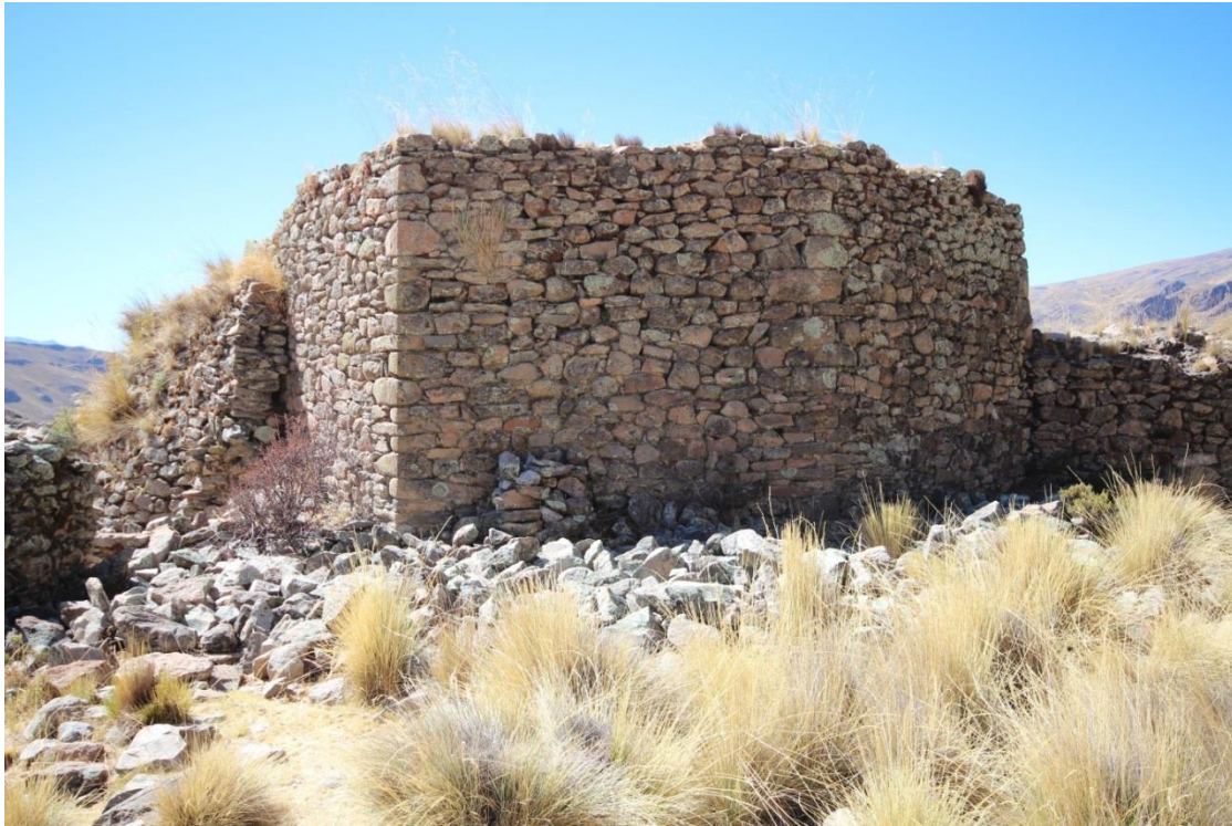
Figura 27. Detalle del ábside ochavado, desde el oeste.
