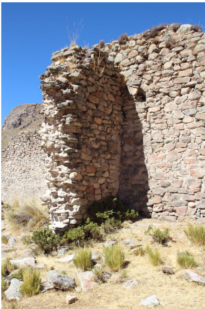
Figura 29. Detalle de contrafuerte (EA-1148) desde el noroeste. Nótese la ventana parcialmente clausurada por el contrafuerte.
