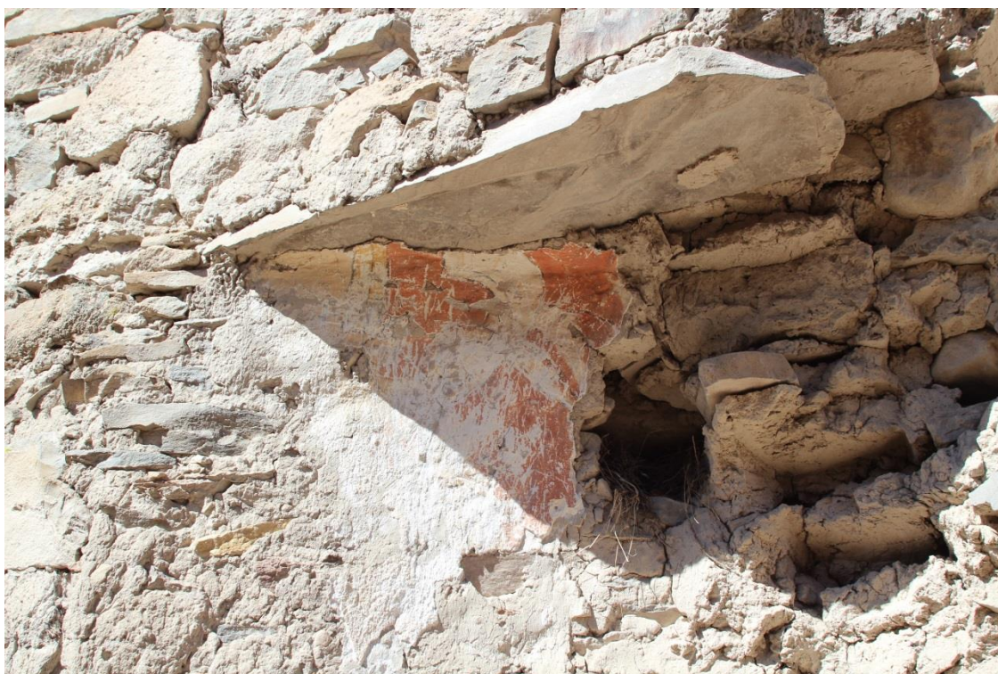
Figura 24. Detalle de la hornacina del altar lateral en la pared sur (lateral) de la nave (ver Figura 22). Se conserva una parte de su enlucido y pintura.
