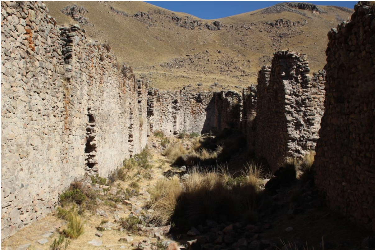
Figura 20. La nave de la iglesia, mirando desde el portal hacia el oeste.
