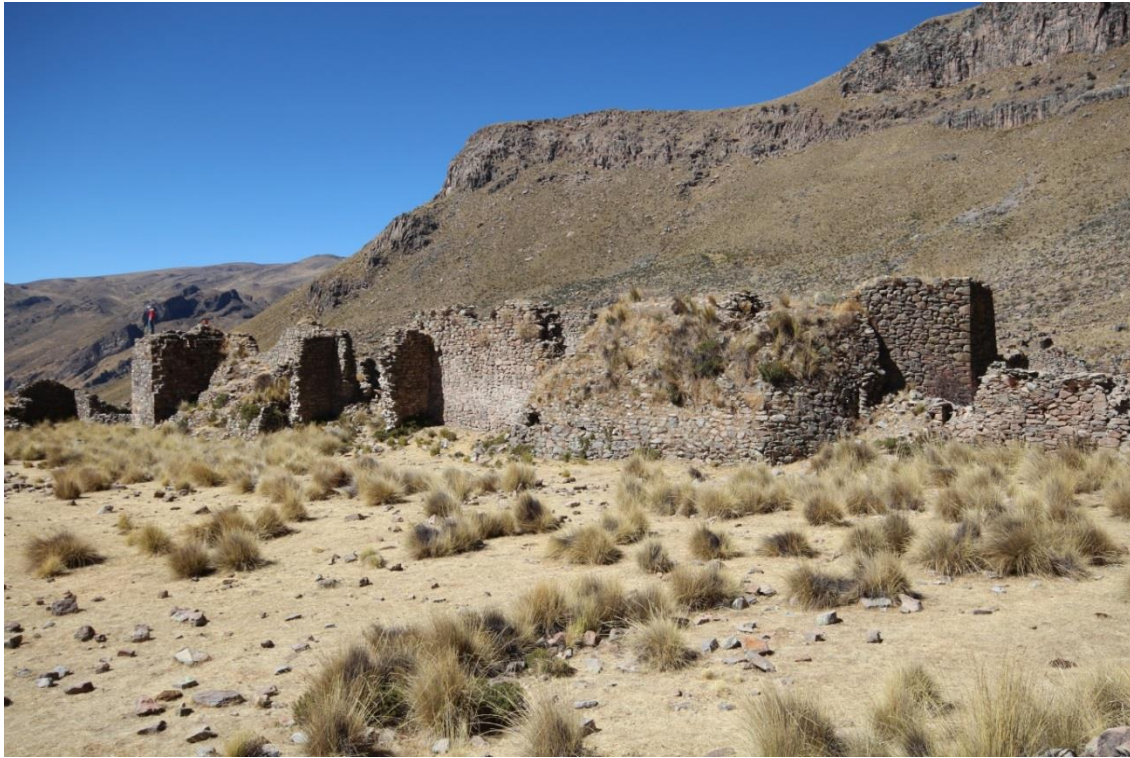
Figura 25. Vista exterior del ábside (derecha) nave y contrafuertes, desde el noroeste.
