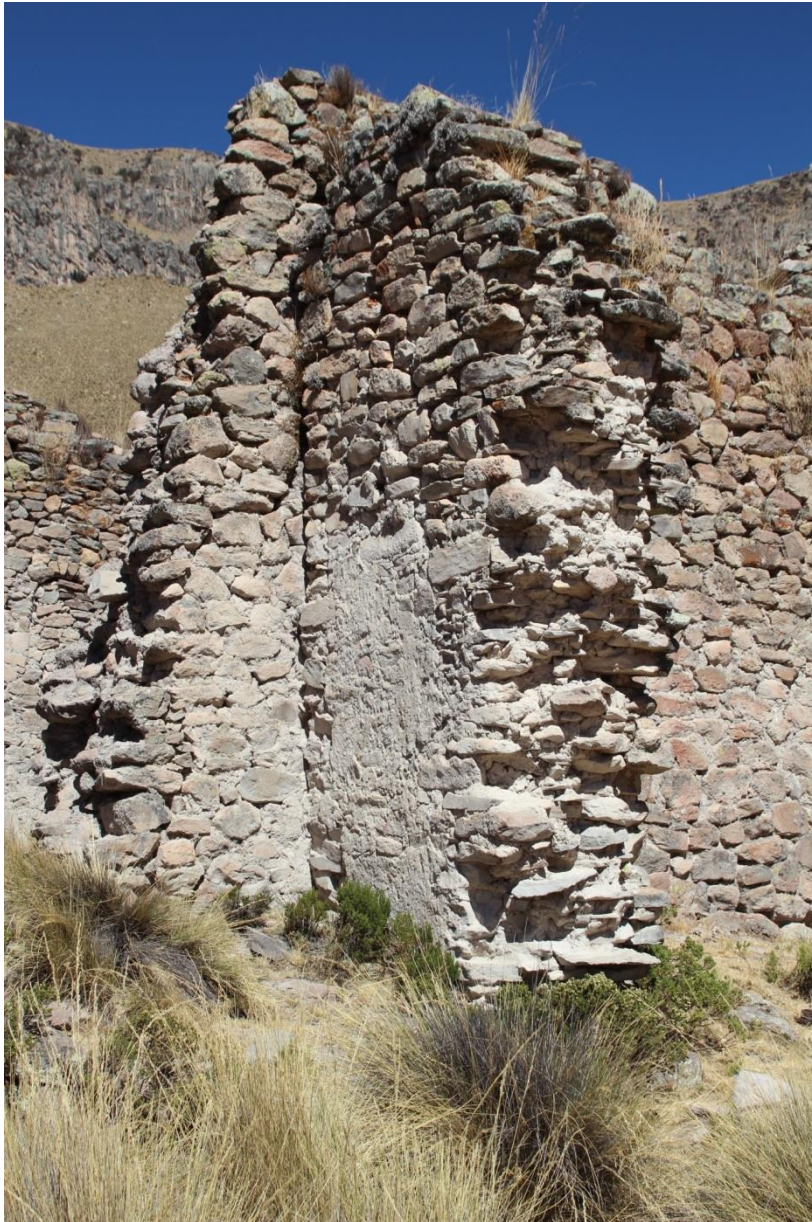
Figura 30. Detalle de contrafuerte (EA-1148) desde el noreste.
