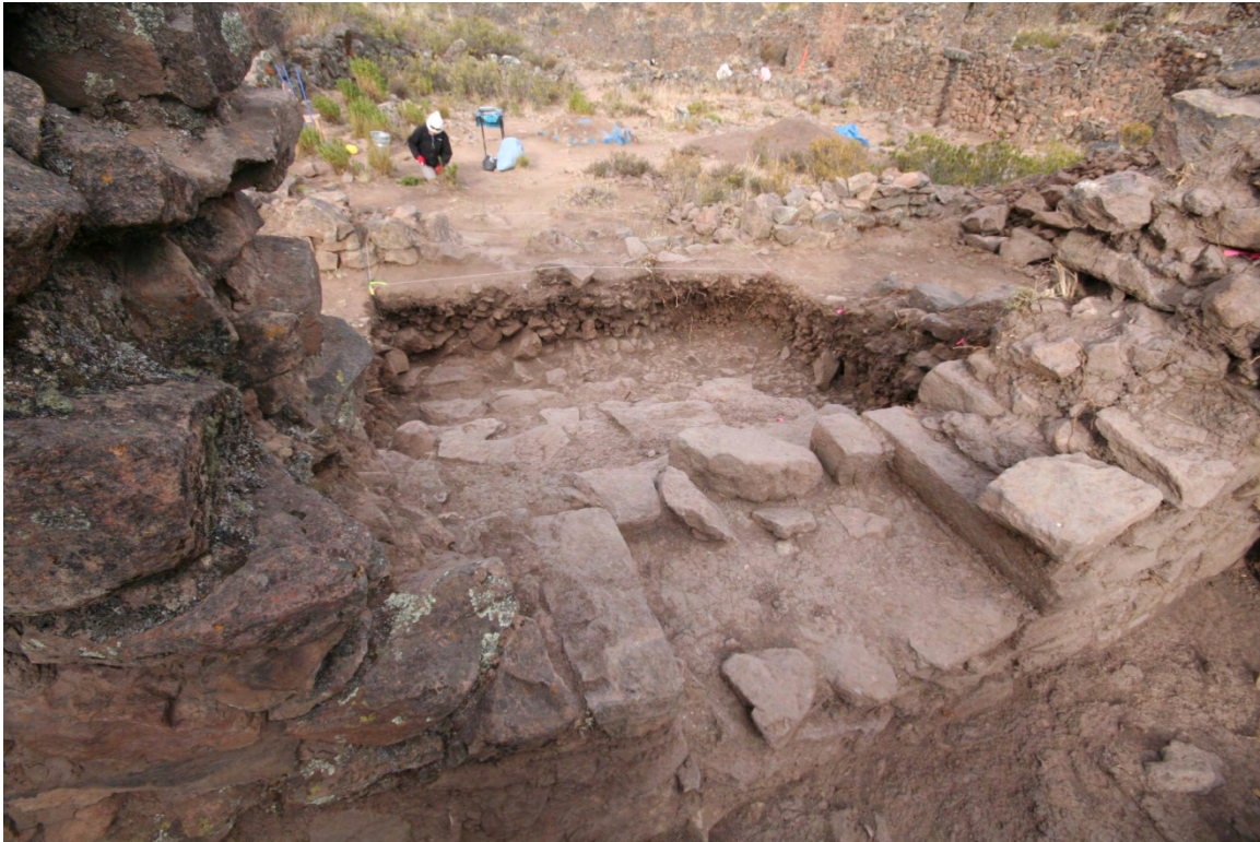
Figura 27. Vista desde el noroeste de la jamba (interior) de la puerta de la capilla, mirando hacia afuera. Foto no. 2386.
