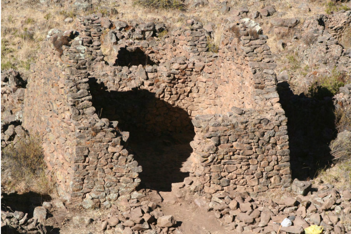
Figura 60. Estructura 026, desde el norte. Foto no. 4446.
